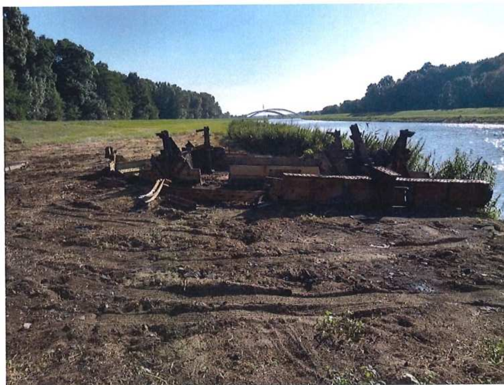
Likvidácia starej mostnej konštrukcie na CZ strane rozpálením
